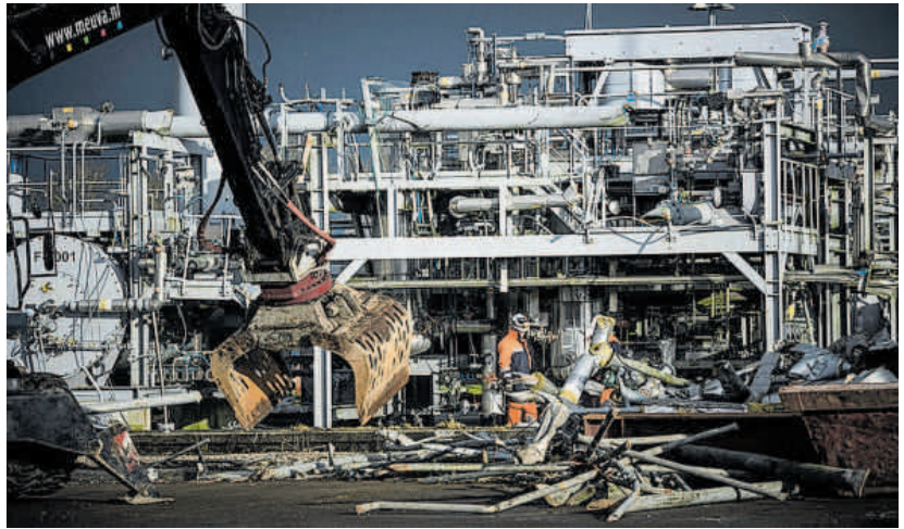
Ontmanteling van de gaswinningslocatie in Ten Post in 2019. Deze locatie maakte deel uit van het Groningenveld. FOTO KEES VAN DE VEEN
